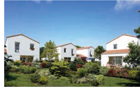
Le Bois Valentin - Saint-Jean-de-Monts Architecte : Agence d'architecture ACDM
