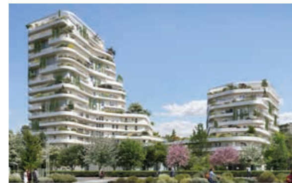
Harmony of the Sky - Saint Nazaire Architecte : Hamonic & Masson
