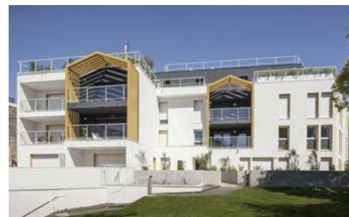
Les Terrasses de Saint-Augustin - Mérignac Agence d'architecture : URB1N
