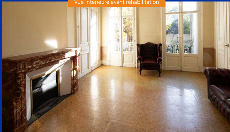
Vue intérieure avant réhabilitation
