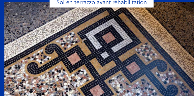
Sol en terrazzo avant réhabilitation
