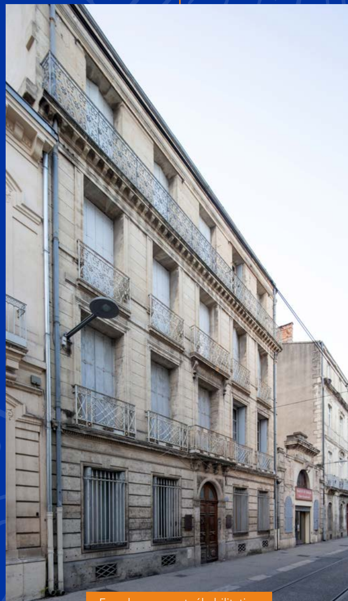
Façade rue avant réhabilitation
