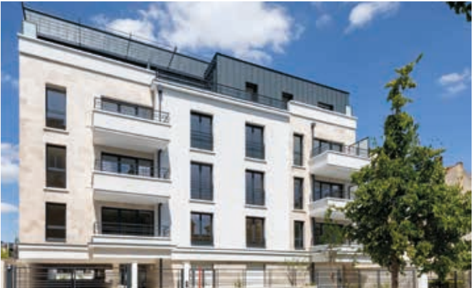
Villa Flora - Fontenay-sous-Bois Architecte : A2D Architecture
