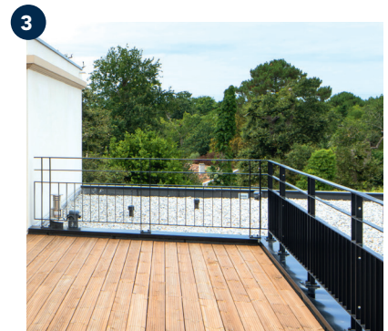
Terrasse en bois en RDC, Terrasse dalles grès cérame en étage
