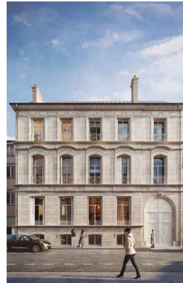
Maison Commandeur Reims
